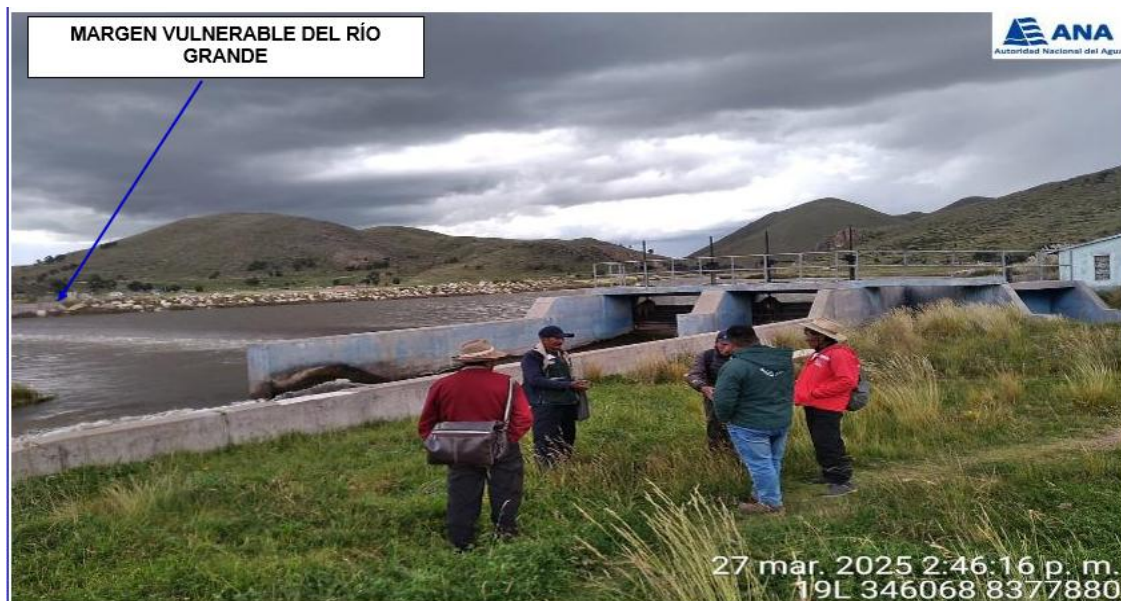
FIGURA N°01: TRAMO CRÍTICO EN EL RÍO GRANDE PRODUCTO DE LA EROSION FLUVIAL EN LA RIBERA DEL RIO PONIENDO EN RIESGO UNA BOCATOMA Y CANAL DE RIEGO EXISTENTE, EN EL SECTOR CHOQUESANI, DISTRITO DE ORURILLO, PROVINCIA DE MELGAR - PUNO.
