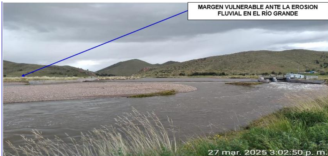
FIGURA N°01: TRAMO CRÍTICO EN EL RÍO GRANDE PRODUCTO DE LA EROSION FLUVIAL EN LA RIBERA DEL RIO PONIENDO EN RIESGO UNA BOCATOMA Y CANAL DE RIEGO EXISTENTE, EN EL SECTOR CHOQUESANI, DISTRITO DE ORURILLO, PROVINCIA DE MELGAR - PUNO.
